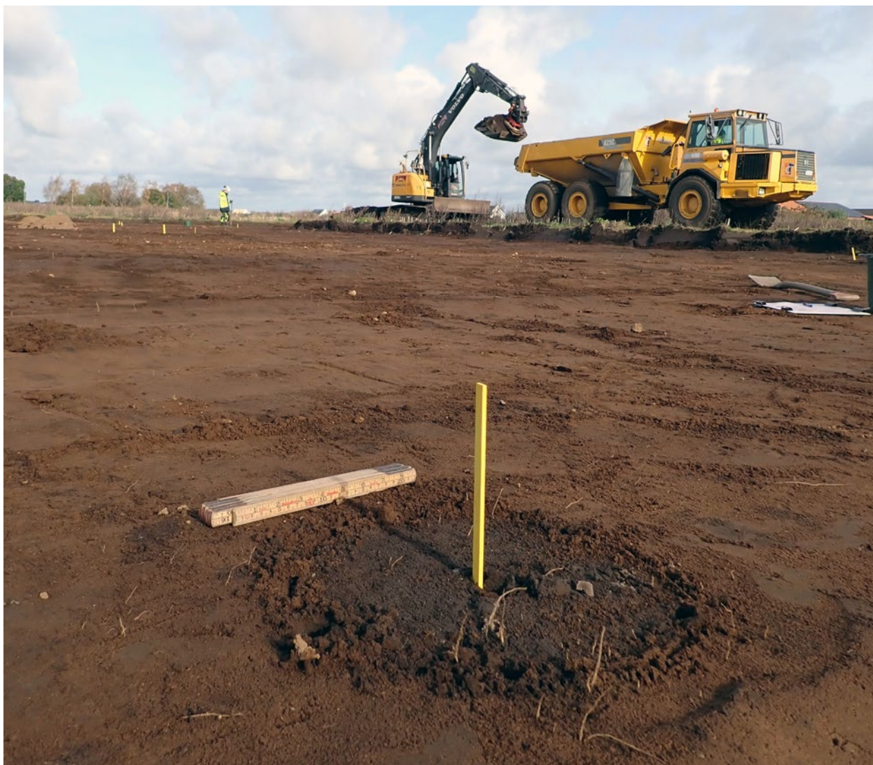
Figur 5. Patrik fortsätter följa avbanningen medan Linda påbörjar undersökningen av anläggningarna. Foto mot NÖ. Fotonummer: 2025-2:2. Fotograf: Linda Wigert.
